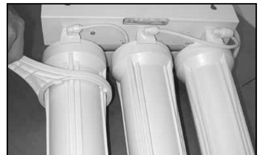
Figure 11: Usage de la clé à carter pour le remplacement des cartouches à filtre.
